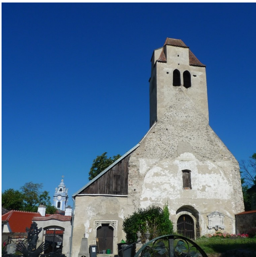
Im Bild: Sanierte Kunigundenkirche
